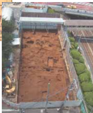
調査区全景(東から) 奥の道路下に日光御成道が眠る
